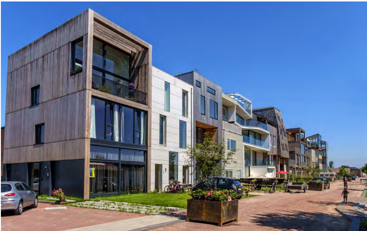
Woningbouw in de Klaprozenbuurt, Amsterdam
