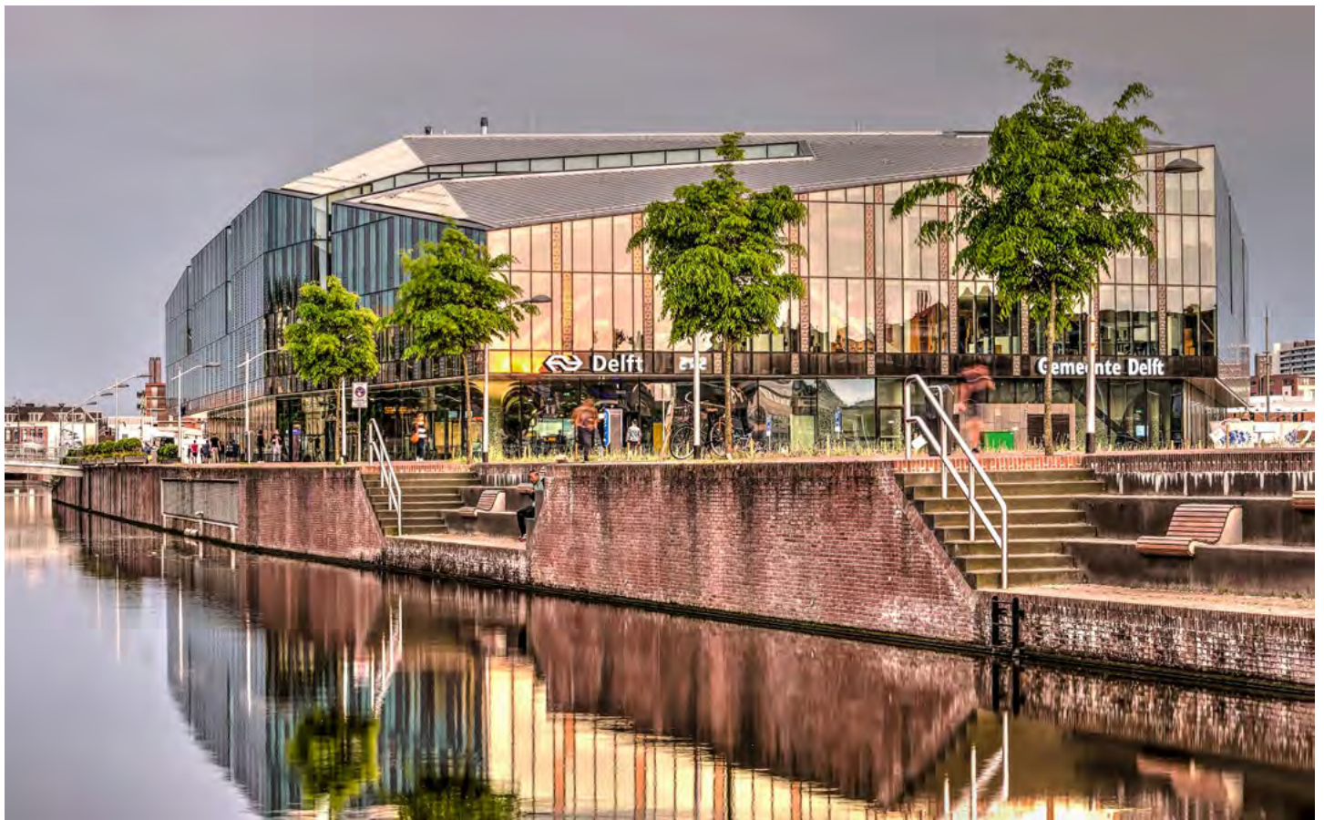
Station Delft als onderdeel van de Spoorzone
