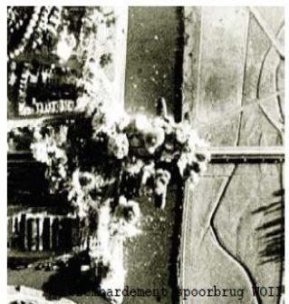
Wardement spoorbrug WOLF
