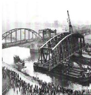
Nieuwe spoorbrug na WOLF
